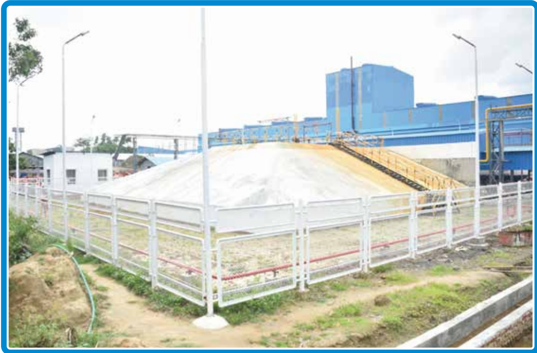
মাউন্ডেড এলপিগি স্টোরেজ সিস্টেম
